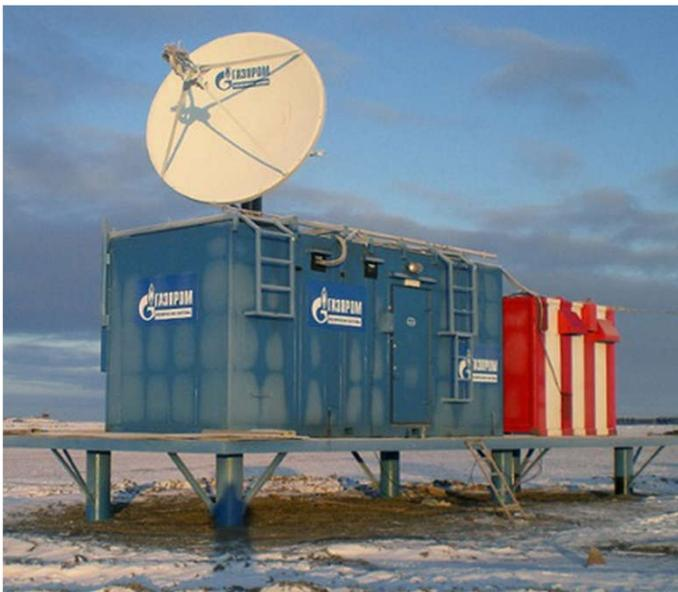
Укомплектовав контейнер необходимым оборудованием можно обеспечить жителей своего населенного пункта беспроводным доступом к сети интернет. Требуется подключение к местным электросетям или дизельной электростанции.
